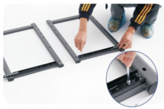
3. 짧은 나사를 사용하여 분해된 슬라이드 레일, 즉 메인 레일을 측면지지대의 해당 구멍에 설치합니다
